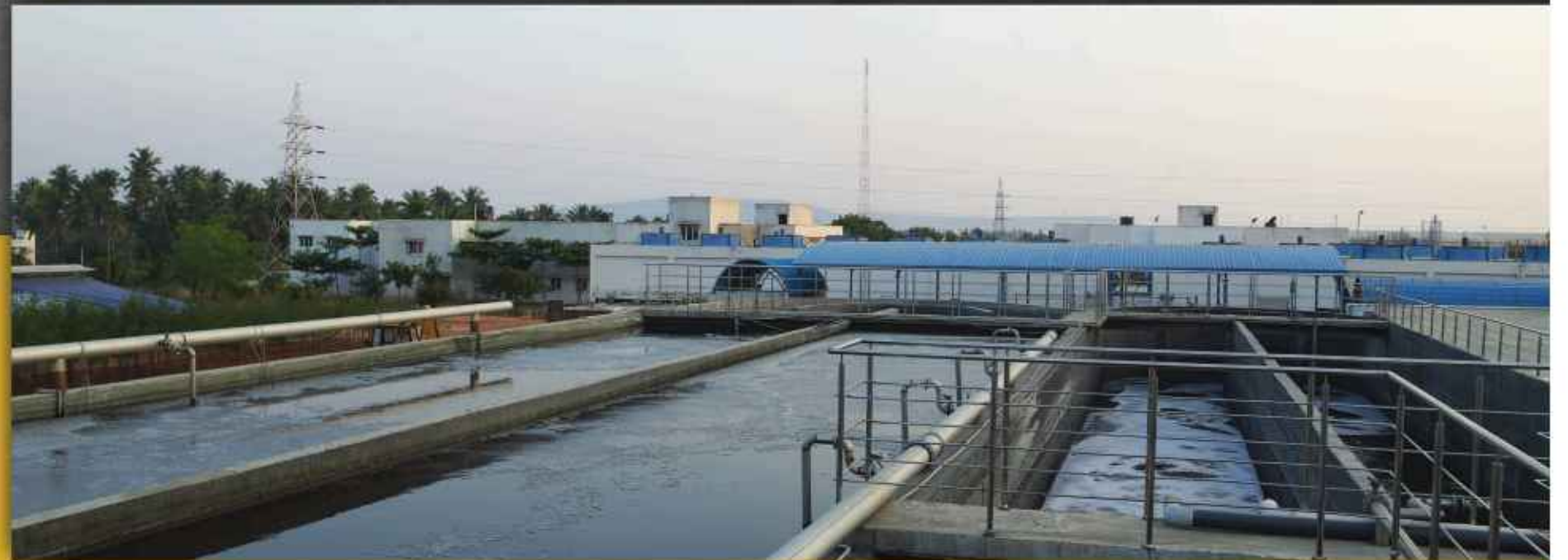
Effluent Treatment Plant, 25 Lakhs litre / Day
